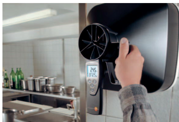
testo 417, monitoraggio del ricambio d'aria in un ventilatore a muro
